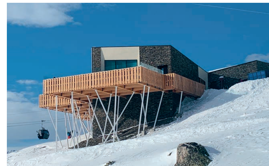
Die drei Terrassen werden von 45 wild angeordnete Stahlstützen getragen.
